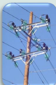
Rehabilitación De Redes
